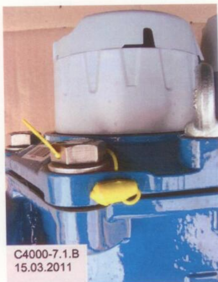
C4000, Plombierung mit Kunststoffplombe, Detail: Sicherung der Deckelschraube
