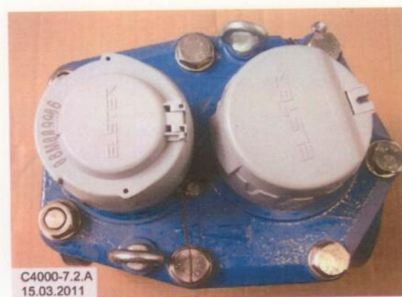
C4000, Plombierung mit Draht, Draufsicht
